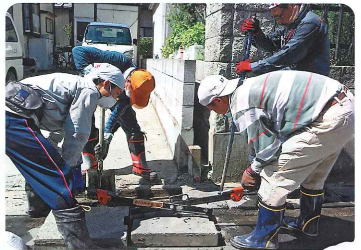
▲特殊な道具を使って側溝の蓋を外します
