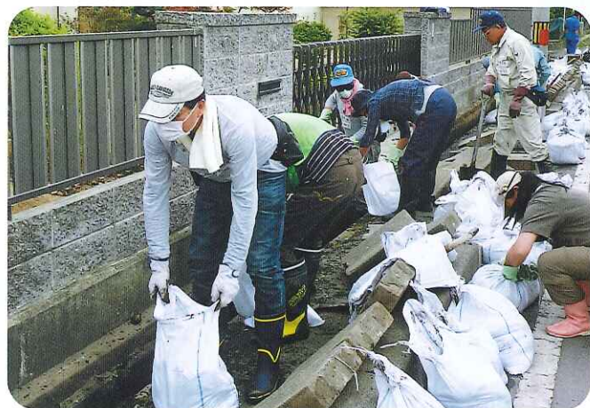
▲側溝に溜まった汚泥は土のう袋へ
